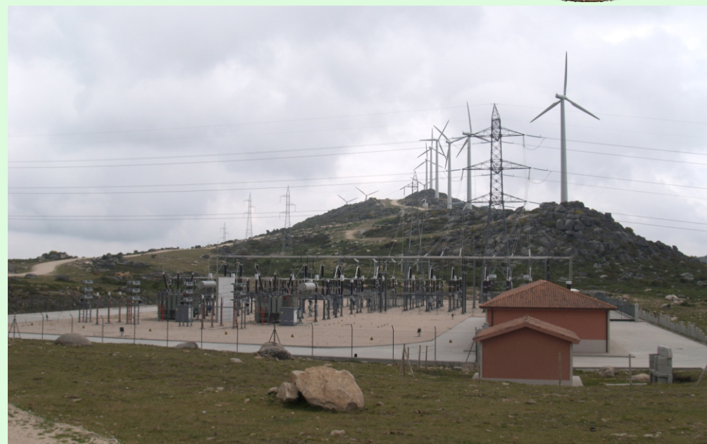
Parque eólico na serra do Faro de Avión.
