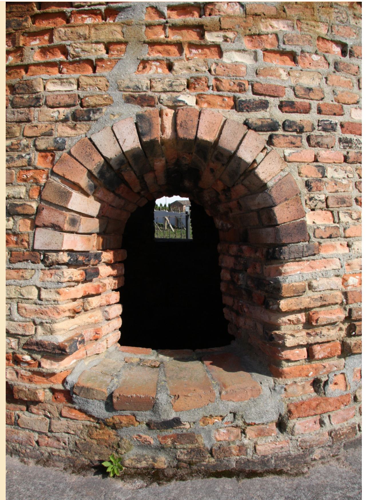
Cheminea da telleira de Dena: ladrillos de cuña.
