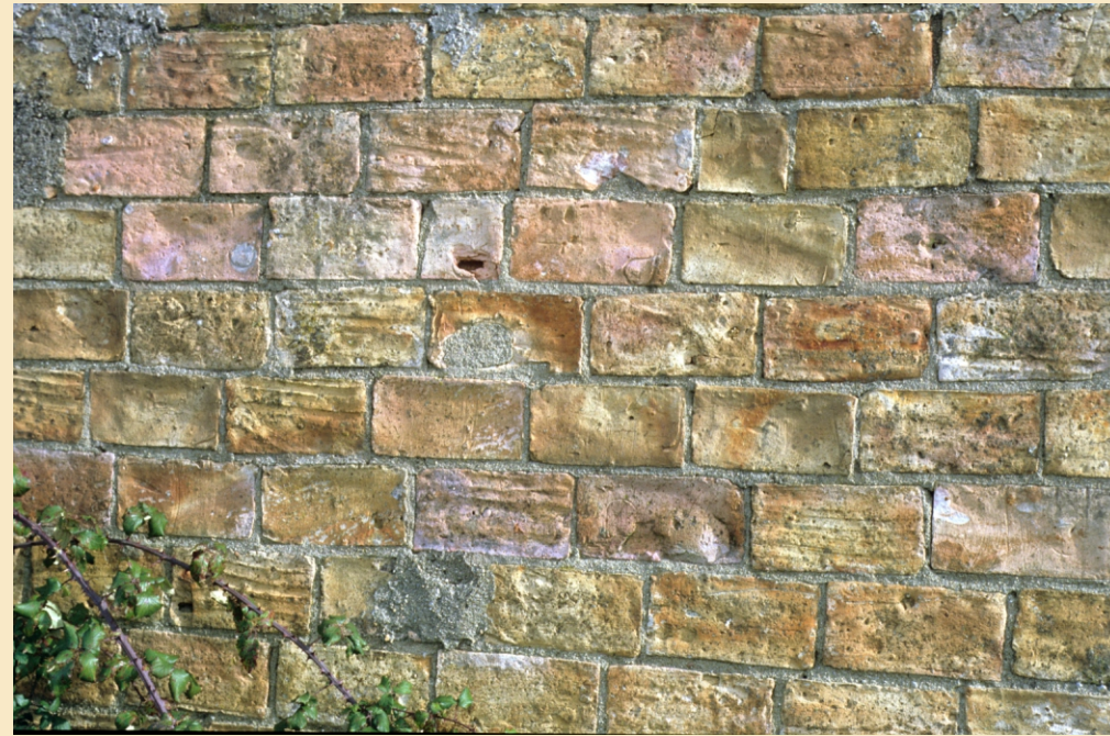
Pared con ladrillos marcados.
